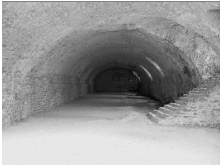
Aufnahme unsaniertes Kellergewölbe
